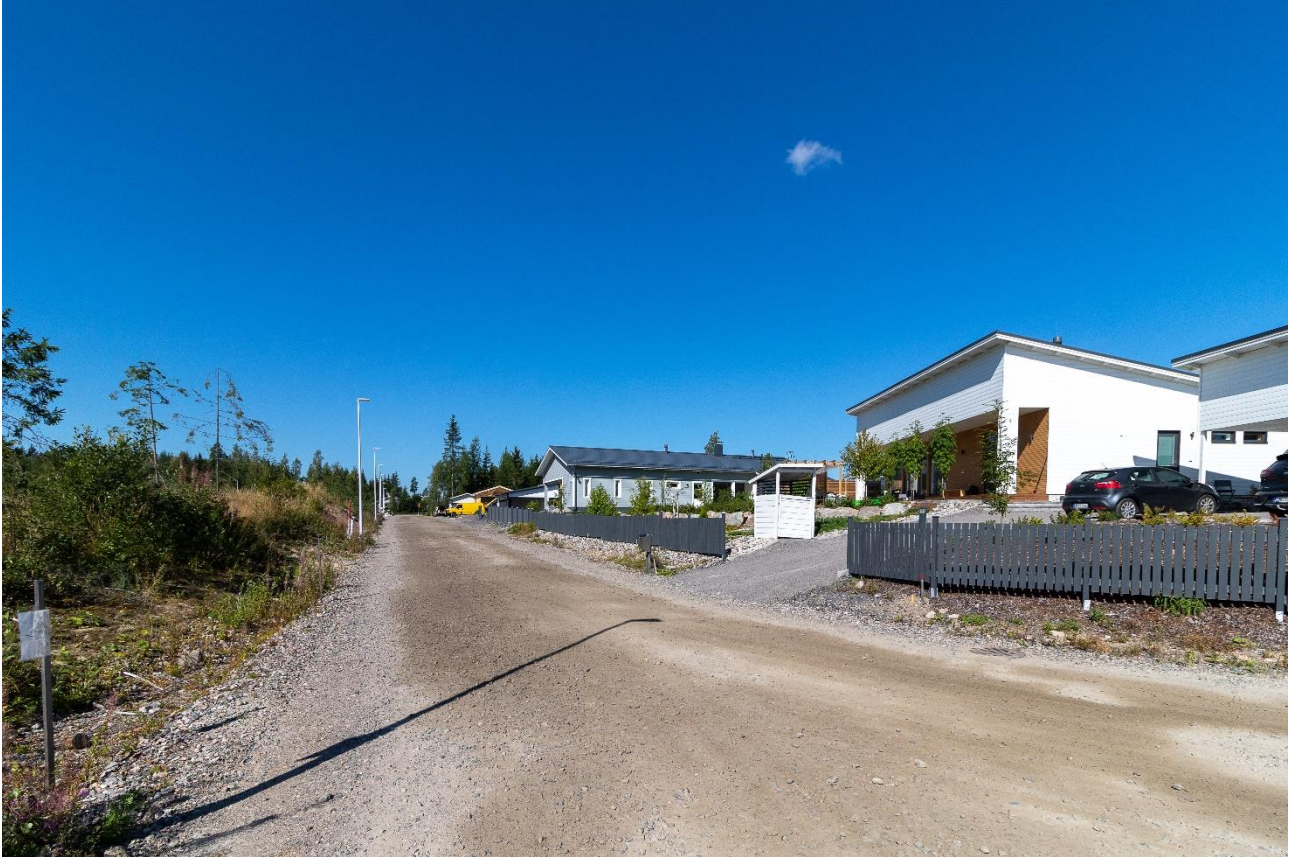
Kuva 3. Palojoenkierron varren rakentamista. Kaava-alue on kuvan vasemmassa reunassa.
