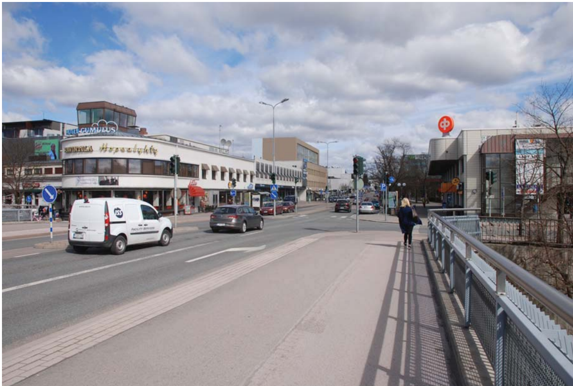
Kuva 8. Näkymä Hämeensillalta. Maalaiskunnan talon katolle sijoittuva uudisosa erottuu ympäristöstään korkeampana rakennusmassana. Se on kuitenkin sisennetty niin, että olemassa olevan rakennuksen muoto säilyy katukuvassa hyvin. Uudisosan värimaailma noudattaa nykyistä rakennusta ja uutuudesta kertoo isot lasipinnat.
